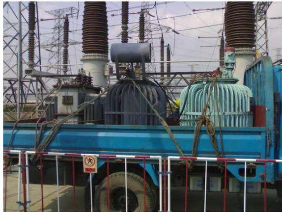
图 1-1 传统测试方法需要的调压器，隔离变压器，三相变压器
